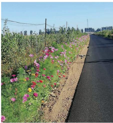
C504 火烧屯—永常村村级路位于巴彦县松花江乡永常村,东起富民村与中兴路相接,西至火烧屯(起点桩号 KO+000,起点名称富民村出口;止点桩号 K3+883,止点名称火烧屯)。于 2018 年 6 月 28 日进行改建,当年 7 月 15 日竣工,全长 11 公里。由原有的水泥混凝土白色路面改建为沥青混凝土黑色路面,改建后路基宽度 6 米,路面宽度 4.5 米,并结合“美丽乡村建设”创建工作对该路段进行绿化,增加了景观绿化带、绿化围栏、交通标识等设施,改造前因超期服役多年,路况较差,多处坑洼,改造后由白色水泥路面改建成黑色柏油路面,路面平整,技术等级为四级的农村公路,有效改善了当地居民出行环境,降低出行成本,带动集体村民经济发展,成为村屯中的一条发展村民经济的致富路、幸福路、文明路。
