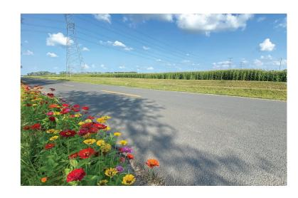
林甸——三合公路,始建于1999年,为沥青表处路面。2018年公路 改建,路面采用沥青混凝土,有效降低了道路反光,提高了道路耐磨性和 抗滑性,采用三级公路技术标准修建,路基宽7米,路面宽6米,沥青混 凝土路面厚度7厘米。同时,在全长30.589公里的道路中,设置各种标志 297块,局部急弯危险性较大的路段,设置了慢字提醒标志。
