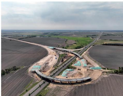
近日,北漠高速五大连池至嫩江段工程建设项目A3标段施工现场一派繁忙。在保障G4512双嫩高速正常通行的条件下,鹤山北互通上跨桥钢箱梁架设任务顺利完成,标志着全线关键节点控制工程取得实质进展。
