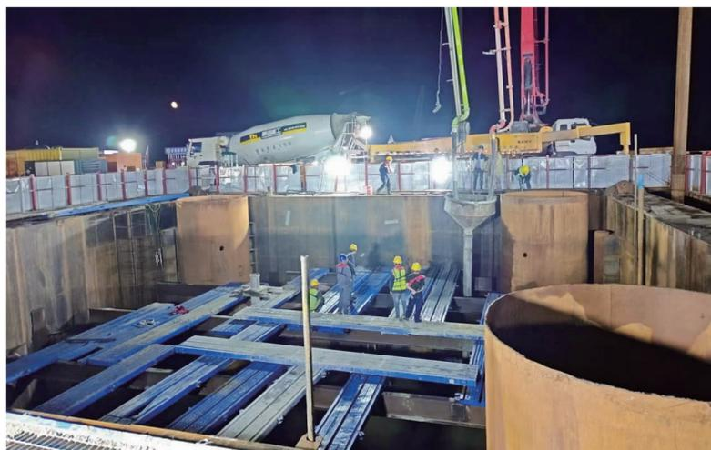
机械轰鸣、马不停蹄,哈尔滨市南岗区西南环项目建设自开工以来,全体参建人员众志成城,攻坚克难,不断取得阶段性成果。6月26日凌晨,松花江特大桥24#主塔围堰成功封底,至此松花江特大桥主塔围堰全部完成,标志着主塔施工涉水难点的攻克,为后续主塔施工奠定了坚实基础。
