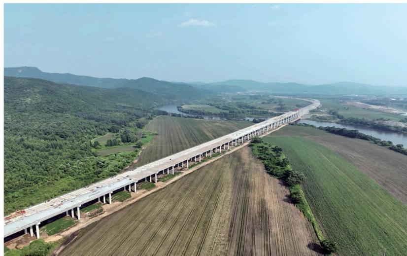
近日,鹤哈高速鹤岗至苔青段B2-2工区顺利完成K97+696汤旺河1号特大桥桥面铺装首件浇筑,由此拉开该桥桥面铺装施工序幕,标志项目控制性工程取得新进展。
