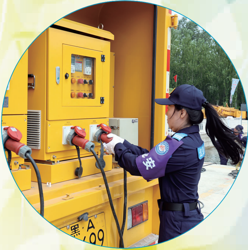
规范操作应急水泵车排水流程
