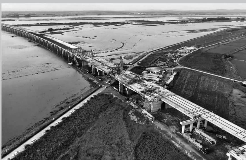
8月8日,随着最后一方混凝土的浇筑完成,由交投工程建设公司鼎捷路桥公司承建的铁科高速通河松花江特大桥首联悬浇箱梁顺利合龙,标志着松花江特大桥重难点工程取得突破性进展,为桥梁的后续施工奠定坚实基础。
