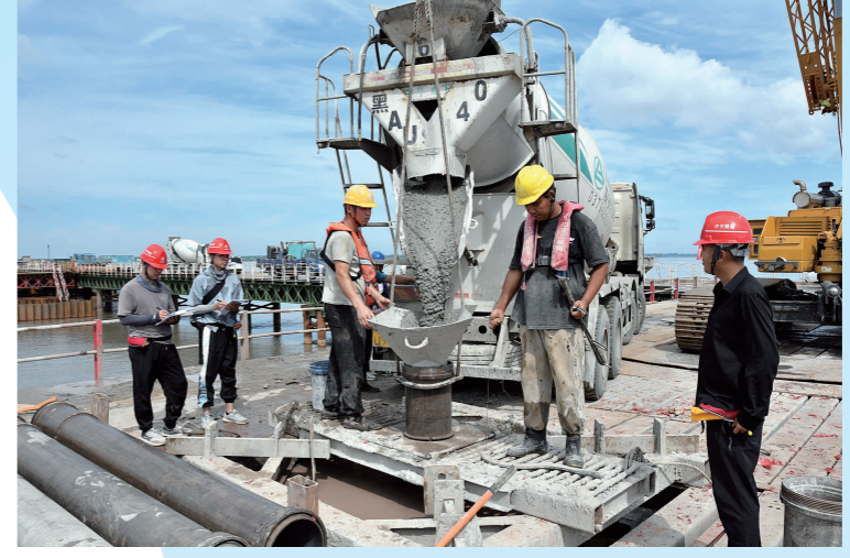
◀ 哈尔滨市都市圈环线北环松花江特大桥梁钻孔桩混凝土浇筑施工
