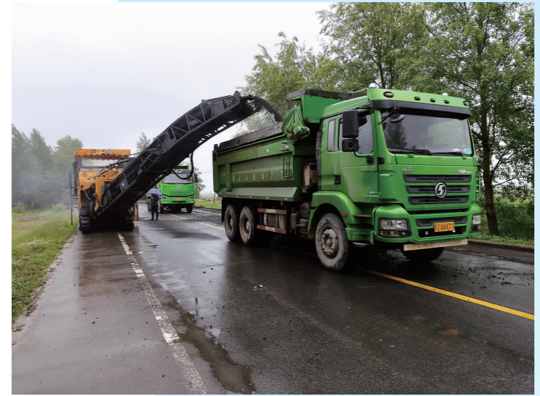
◀ 国道丹阿公路(G331)K2240000-K2252200段路面进行铣刨,收集再生料作业
