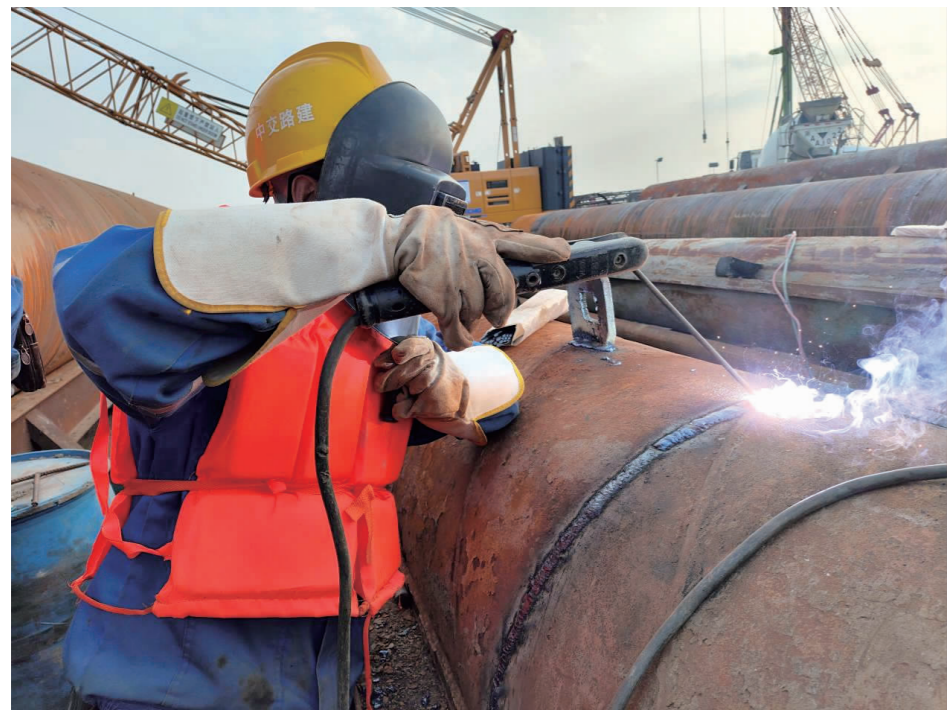
▲ 哈尔滨市都市圈环线北环永双段松花江特大桥梁主航道桥主墩围堰钢管桩焊接
