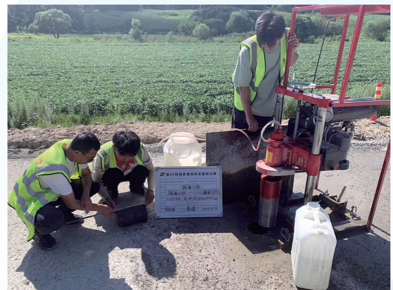
◀ 绥马项目建设者进行水稳基层现场取芯
