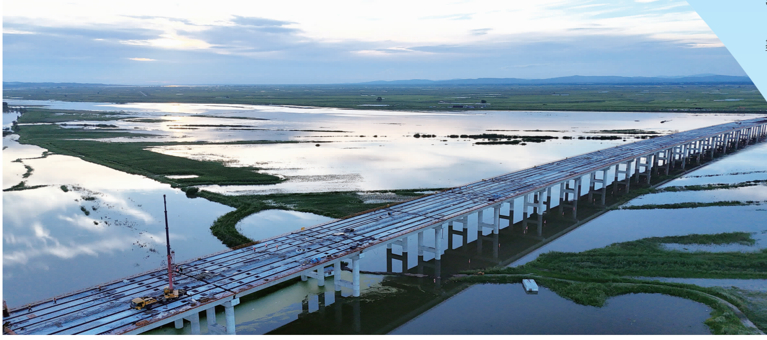
▲ 铁科通河松花江特大桥梁桥面系施工
