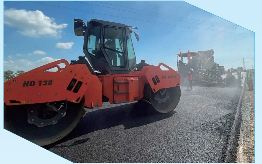
▲ 国道绥满公路大庆段改扩建工程进行沥青路面施工
