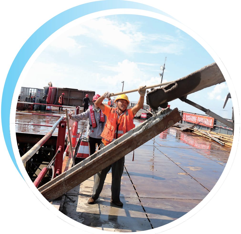
▲ 哈尔滨都市圈北环松花江特大桥备用航道桥主塔承台混凝土浇筑
