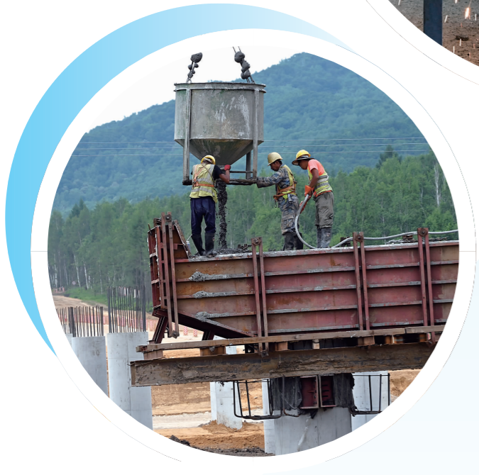
▲ 鹤伊项目进行桥梁盖梁施工
