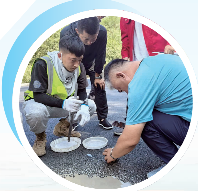
▲ 亚雪项目 A1 标段 AC-20C 下面层取芯检测
