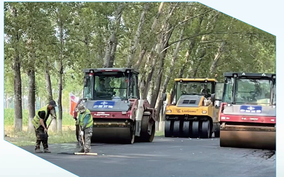
▲ G331 国道丹东至阿勒泰公路 K1962184-K1981800(虎林路段), 养护工人在铺设沥青面层
