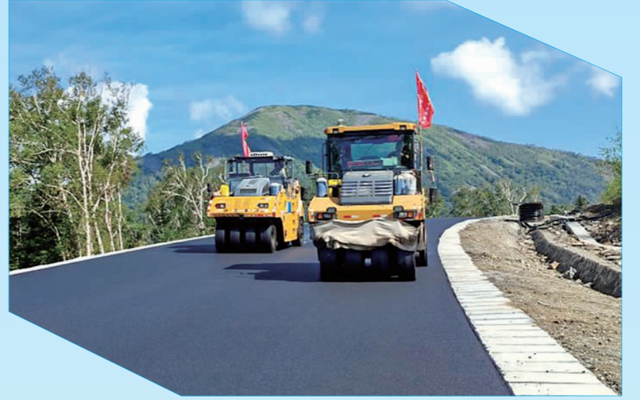
▲ 亚雪项目 A1 标段 K543500-K544000 中粒式沥青混凝土 AC-16C 上面层碾压施工
