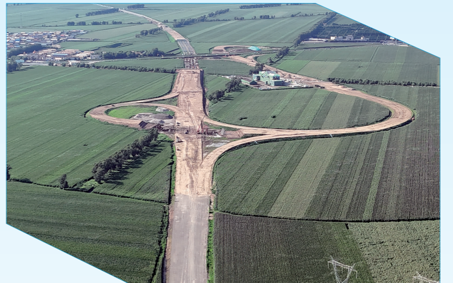
▲ 哈尔滨都市圈西南环新胜互通匝道路基填筑施工
