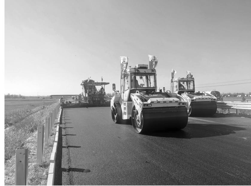
10月11日,黑龙江省农垦建工路桥有限公司(河南)上罗项目SLZT-5标沥青上面层试验段摊铺现场机械轰鸣,伴随着最后一车沥青混合料缓缓倒入摊铺机料斗,标志着农垦(河南)上罗项目沥青上面层试验段顺利铺筑,拉开了项目路面最后一道工序的帷幕,吹响了“决胜通车”的冲锋号,为2022年项目建成通车奠定了基础。
