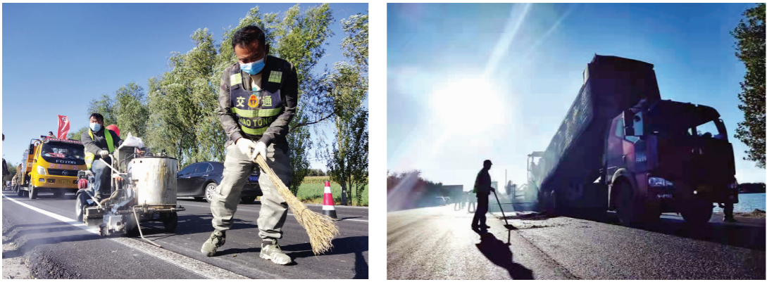
公路质量提升建设现场如火如荼:
