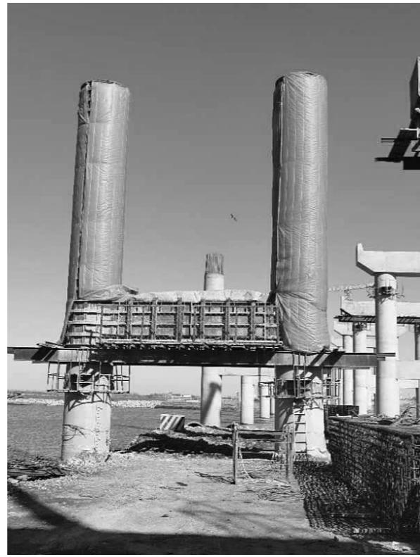
护,强度达到设计要求。为保证质量,我们搭建了保温大棚,利用电采暖等方式将工作区域的温度提升,做到冬季不停工、质量有提升、建设再提速,保证施工进度全线领先。”
