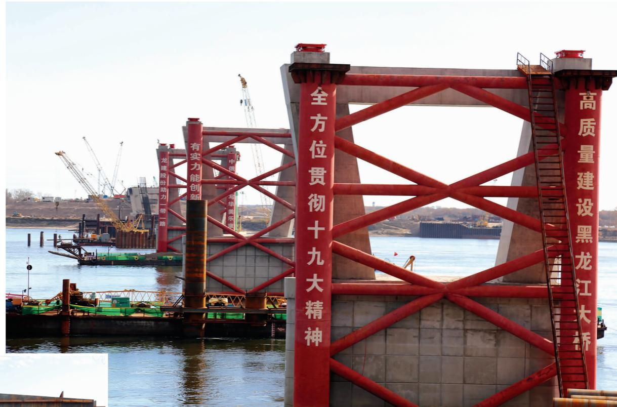
和墩侧临时墩,预计一共要搭建12个临时墩,并准备在“十一”之后实施江中跨中顶推临时墩的安装作业。
