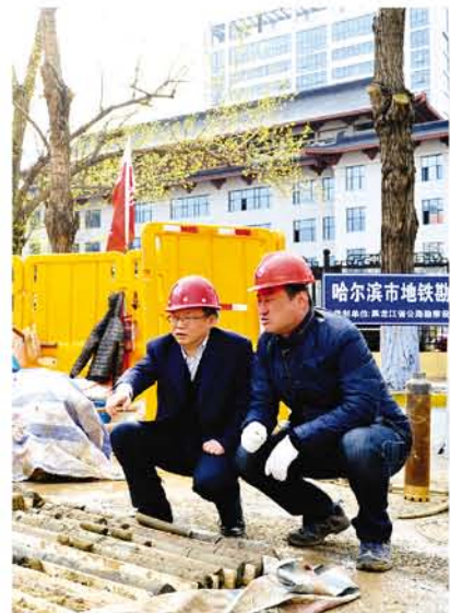
齐琳在地铁4号线勘察现场
