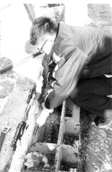
近日,尚志处监控中心在按计划做好日常设备维护管理的基础上,全员深入一线收费站排查隐患,解决问题,及时排除各类设备故障,为收费工作顺利进行提供强有力的技术保障。2月24日,尚志处收费站设备发生故障。接到报修信息后,监控中心立即出发,全员赶赴尚志处进行抢修。现场需要吊起秤体解决线路问题,由于气温低,秤室外场设备缝隙结冰,不可能直接吊起。维护人员没有畏惧,趴在地上,用手锯、气焊等工具进行人工除冰,历时6个多小时,终于修复了两套通道的计重设备,用最短的时间,确保了收费站的正常运行。李健民 通讯员 姜梅 摄影报道
