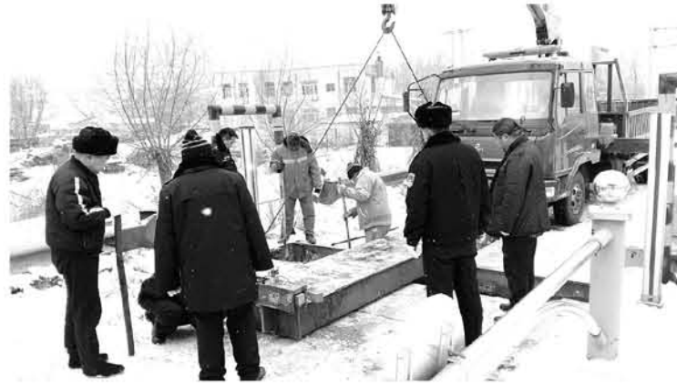
近日,尚志处监控中心在按计划做好日常设备维护管理的基础上,全员深入一线收费站排查隐患,解决问题,及时排除各类设备故障,为收费工作顺利进行提供强有力的技术保障。2月24日,尚志处收费站设备发生故障。接到报修信息后,监控中心立即出发,全员赶赴尚志处进行抢修。现场需要吊起秤体解决线路问题,由于气温低,秤室外场设备缝隙结冰,不可能直接吊起。维护人员没有畏惧,趴在地上,用手锯、气焊等工具进行人工除冰,历时6个多小时,终于修复了两套通道的计重设备,用最短的时间,确保了收费站的正常运行。李健民 通讯员 姜梅 摄影报道
