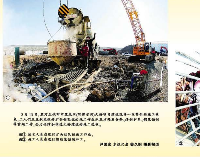
2月13日,黑龙江(阿穆尔河)大桥项目建设现场一派繁忙的施工景象,工人们正在积极做好扩头钻孔桩的施工以及沙砾石备料、深埋护筒、钢筋预制等前期工作,全力保障和推进大桥建设的施工进度。
