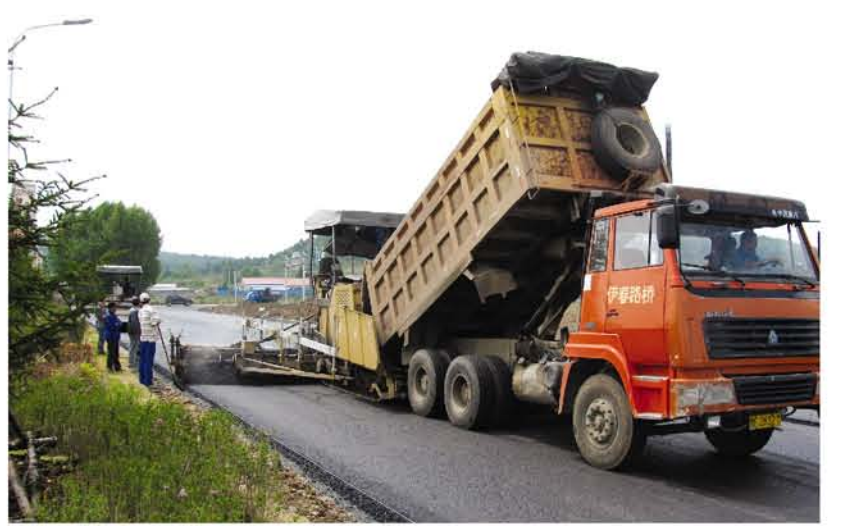
公路路面施工
