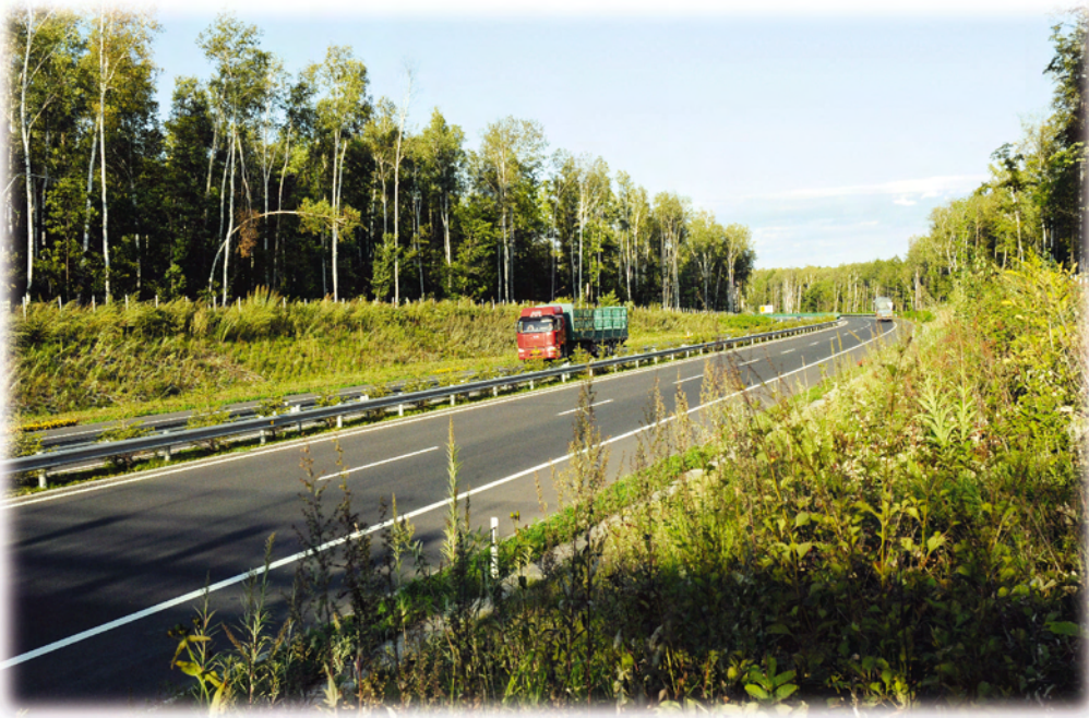
盘道沟险绕山梁
