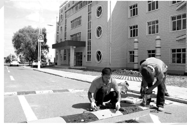
日前，九三交通运输局在总局交通运输局的支持下，为九三管理局9个农场中小学、幼儿园和局直中学门前道路安装了减速带。共为全局24所中小学、幼儿园安装减速带33条381.1米。因为工人在尖山农场小学门前道路安装减速带。
